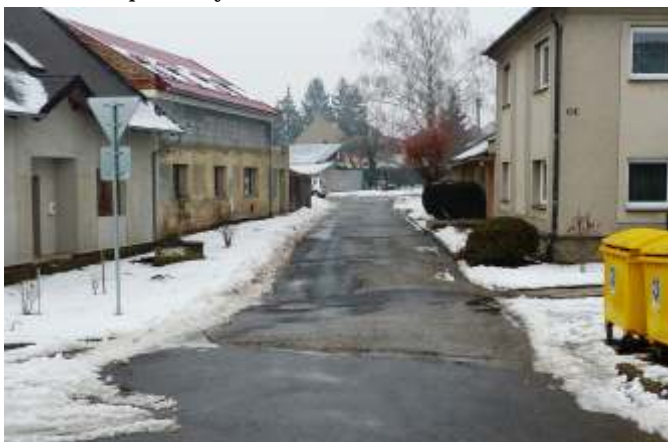
Upraven bude i povrch komunikace vedoucí podél rodinného domu Svákových po křižovatku u Kreuzerů.
